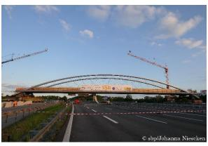
架设在斯图加特近郊 A8 高速公路上的城铁大桥是全长 127 米的铁路用拱桥,通过使用强度重量比高的 CFRP 制缆索,实现了不用支柱就能横跨 8 车道高速公路的结构。
